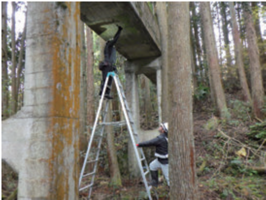
水路橋点検状況
