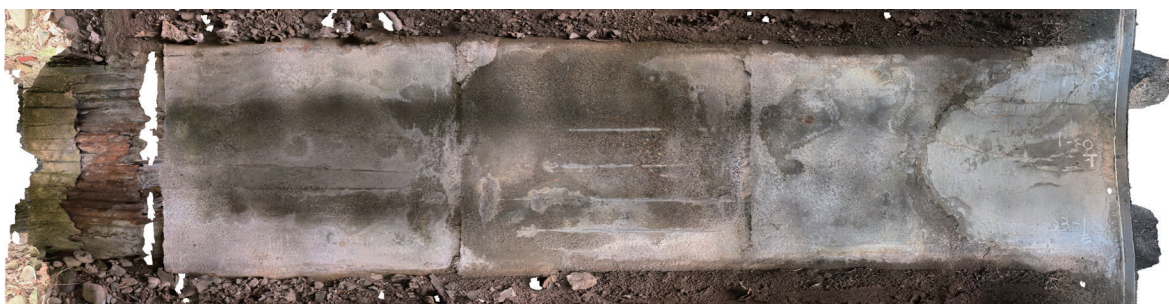
ポールカメラで撮影した管内の連続写真
