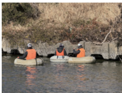
フローター点検状況
