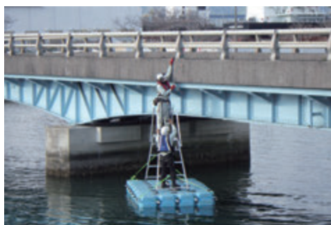
フロート足場
