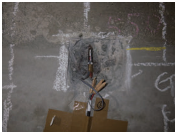
ひずみゲージ取付状況
