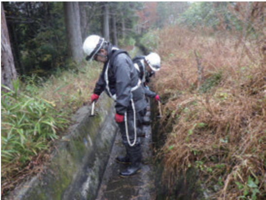
開水路点検状況
