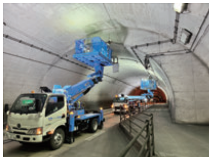
トンネル点検状況
