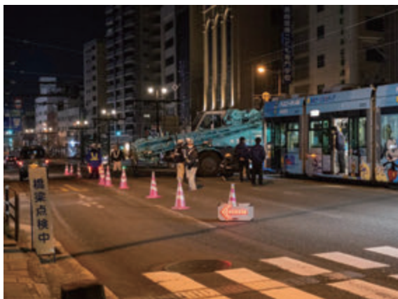
載荷試験状況
