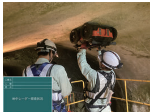
トンネルの空洞調査状況
