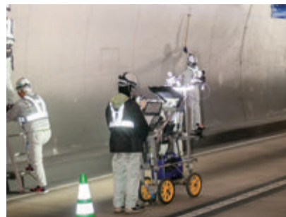
覆工画像撮影状況
