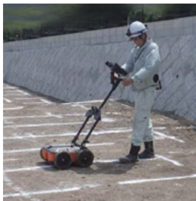
宅地の空洞調査状況
