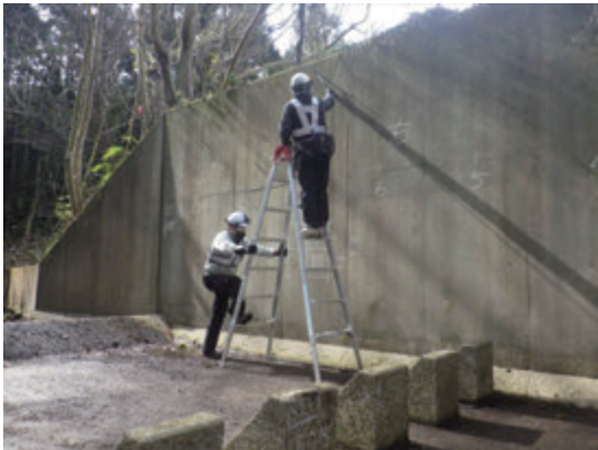
ダム点検状況
