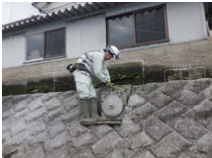
樋管点検状況
