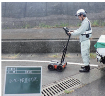
道路の空洞調査状況
