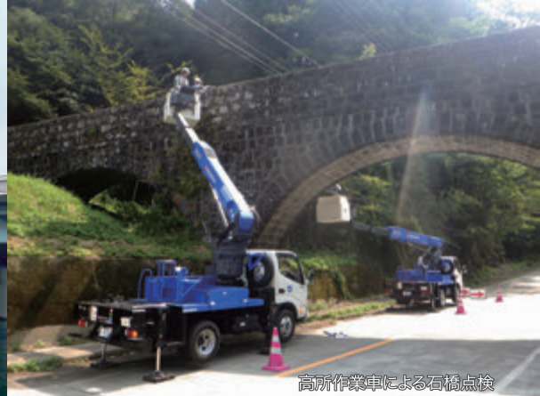
MOOG による橋梁点検
